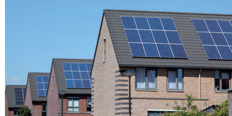
Zonnepanelen zijn een interessante investering.
